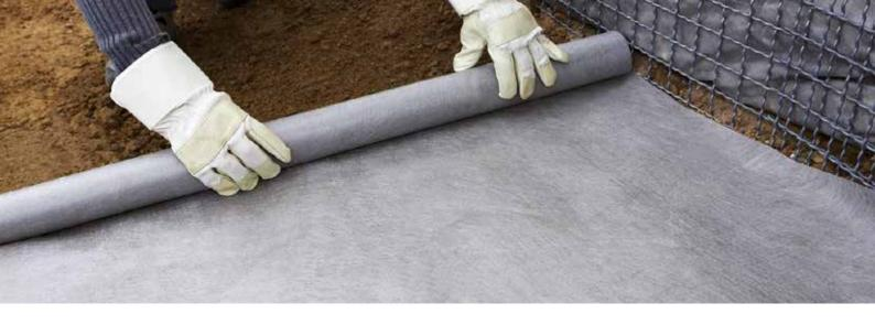
DuPont™ Plantex® Geoproma® è un geotessile 100% polipropilene termolegato e resistente alla putrefazione. Evita la perdita di sostegno nel sottosuolo e previene la migrazione di terra nei sistemi di drenaggio. Plantex® Geoproma® garantisce una costruzione uniforme e duratura. Le sue proprietà di filtrazione consentono un drenaggio costante. È chimicamente inerte, non si deteriora e rispetta l'ambiente.
